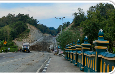
[ PROSES PEMBANGUNAN INFRASTRUKTUR YANG MENGHUBUNGKAN PRAMBANAN - GAYAMHARJO, 2025 ] [ FOTO : IRUEKKAWA ELISA ]
